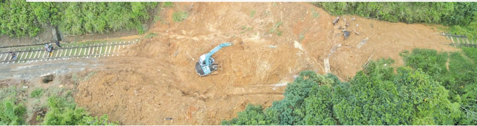
දුම්රිය මාර්ගයට කඩාවැටී ඇති පස්කඳු බැංකෝයන්තුයක් මඟින් ඉවත් කරමින්
